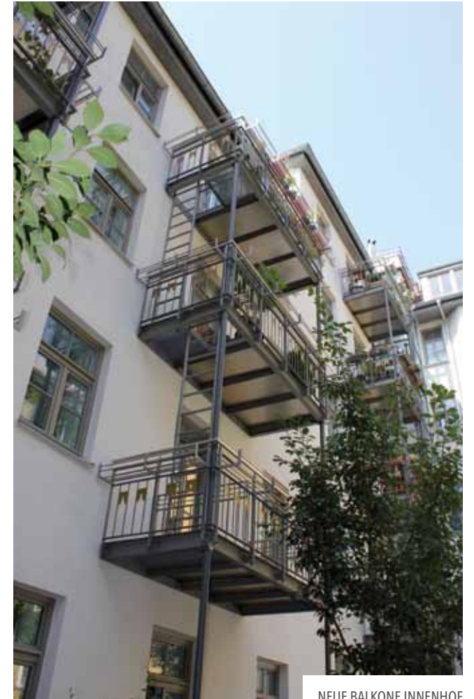
NEUE BALKONE INNENHOF
